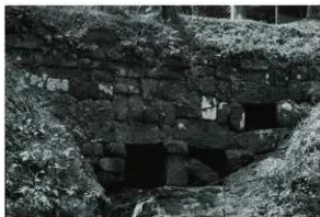
写真9 雷山神籠石北水門(城外側)(北より)
