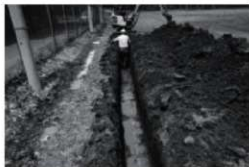
D. 札幌団地基幹整備（学寮地区給水設備）工事（南東より）調査番号：2105
