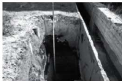
C. 工学部資源棟新営工事 TP 08（西より） 調査番号：2120
