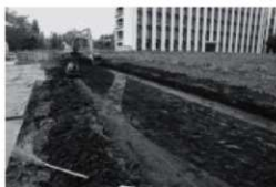
B. 北キャンパス第二農場農道舗装工事（北より）調査番号：2103
