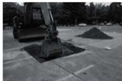
D. 調査の様子 (TP 06: 北東より)
