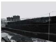
B. 北壁の様子 (セクション：南東より)
