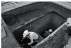
B. 調査の様子 (TP 14:北西より)
