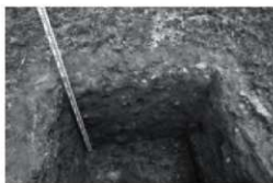
H. 学術交流会館空調設備改修工事 TP01（西より）調査番号：2113
