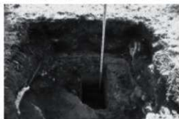
E. 大学病院院外薬局新営工事 TP 02（北より）調査番号：2129
