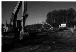
1. 現道下盛土除去状況(E→)
