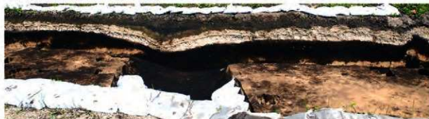
2. 溝跡断面1(SE→)
