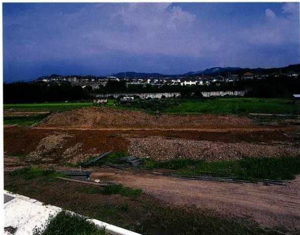
井関遺跡 石積み遺構15断割り全景
