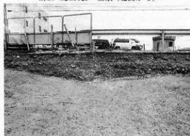
溝10断面 近景(南から)
