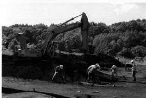
5. 重機によるV層掘削状況
