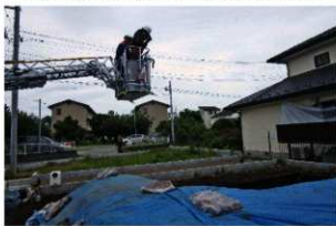
3. II区全景写真撮影状況
