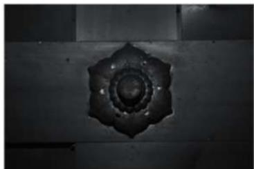
図 239 金剛峯寺護摩堂釘締し六葉金具
