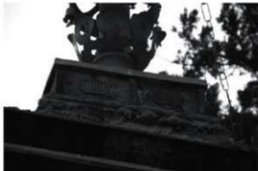
図 561 金輪塔露盤
