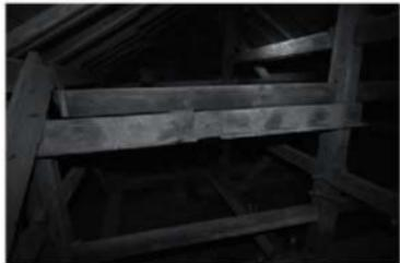
図 578 女人堂小屋組、櫛輪欠き・釘彫りを施した長押軒用材
