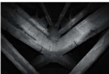
図383 墓上伽藍根本大塔鉄骨鉄筋コンクリート造躯体
