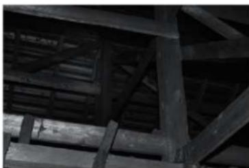
図 503 塙上伽藍愛染堂小屋組棟札打ち付け状況
