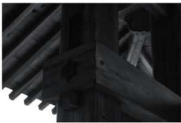
図 343 六時鐘樓側柱内法長押上の胴差痕跡
