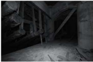
図 376 墓上伽藍根本大塔初重小屋組丸桁桔尻手納まり
