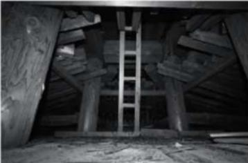
図 559 金輪塔小屋組四天柱納まり
