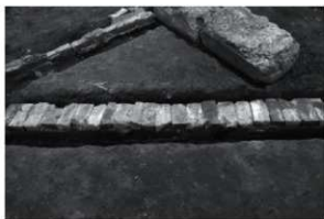
レンガ蓋レンガ積排水路（大廊下南端）
