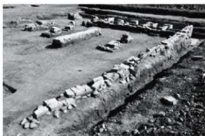
教室：南側壁基礎 SB152 (南西から)
