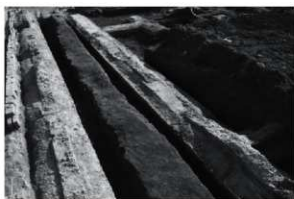
菊寮のコンクリート基礎（台形断面）
