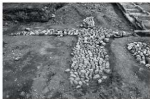
梅寮：壁基礎 SB212（西から）
