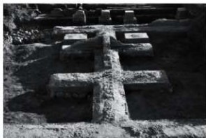
菊寮：壁基礎 SB292 (北から)
