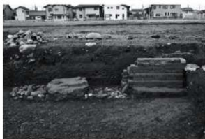
隔離室東様のレンガ積み壁基礎
