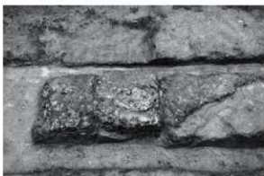
仏間：柱基礎 SB182（西から）
