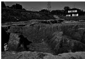
21SX3断面 (東から)
