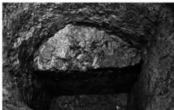
50SE3 断面 (西から)
