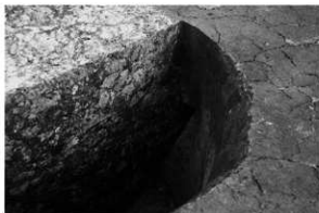
77SK2 壁面挟れ部 (北西から)
