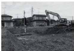
図3 表土除去作業
