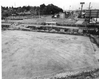
a. 北東側掘溝全景(南から)
