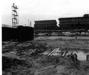
写真92 99-1調査区調査前風景(北から)
