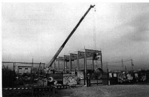
写真3 98-3調査区立坑本体工事風景(東から)
