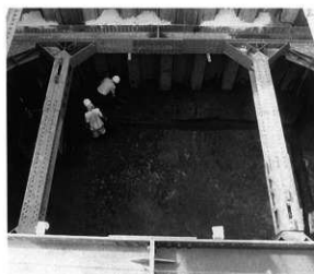
写真88 最終人力掘削面 (南から)
