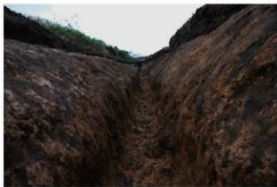
第8次調査区第3・4号溝跡 (東から・底面の掘削痕跡)
