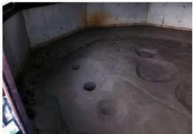
写真 4-9. 擬土塗り作業完了①
