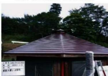
写真 5-15. 塗装工事 上塗り塗装完了
