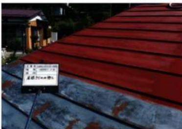
写真 5-12. 塗装工事 鋼止め塗装状況
