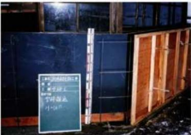
写真 1-6. 基礎工 型枠組込
