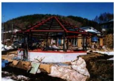
写真1-15. 鉄骨工 建方②
