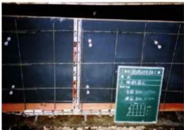
写真1-4. 基礎工 鉄筋
