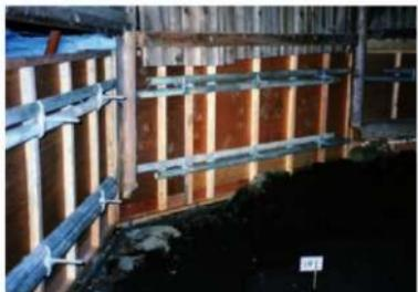
写真 1-5. 基礎工 内側型枠
