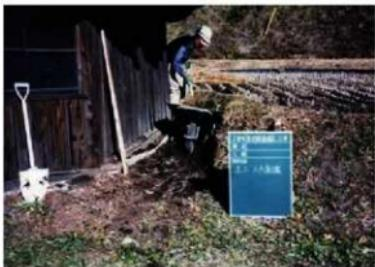
写真1-2. 土工 人力床掘
