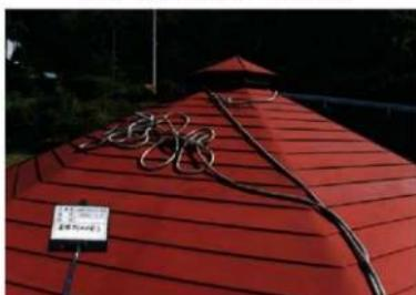
写真 5-13. 塗装工事 鋼止め塗装完了
