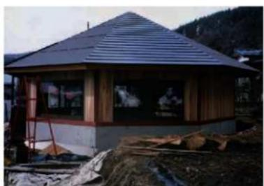
写真1-17. 屋根工 長尺平葺き
