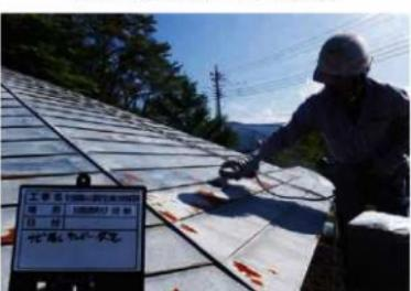
写真5-10. 塗装工事 下地処理①
