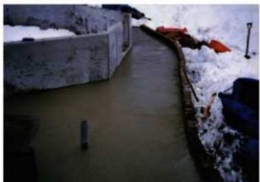
写真1-13. 外構工 コンクリート打設出来形
