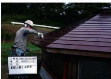
写真 5-14. 塗装工事 上塗り塗装状況
