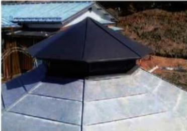
写真2-2. 完成 棟部換気穴
