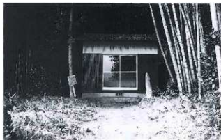
写真55 道脇寺観音堂
