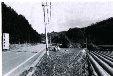
第10図 通称「大石」 道と橋の間に巨岩が ある
