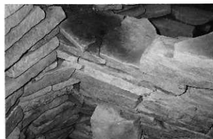
5. 割れた石材（北長側壁西隅）
