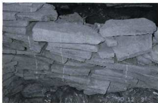
1. 北長側壁西部の修復準備
