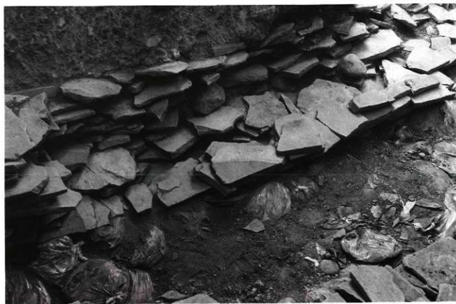
控積みの状況（南長側壁東部）
