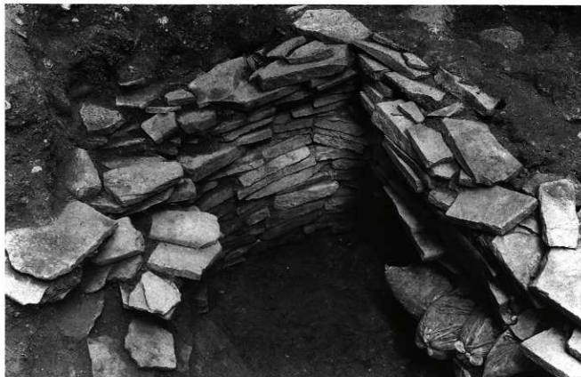
修復前の西短側壁
