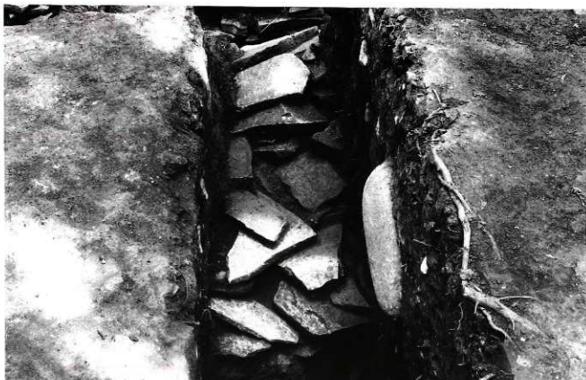
東短側壁控積み（東より）
