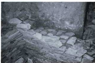
8. 同 修復完了（この後新設積層）
