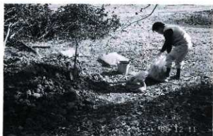
2. 壁穴式石室修復に用いる粘土の練込作業
