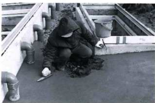
7. 填頂部のソイルセメント
