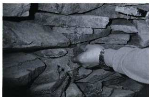
4. 同 側壁裏込めの接着
