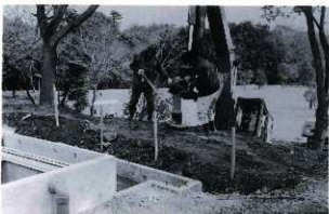
6. 填丘盛土の締め固め
