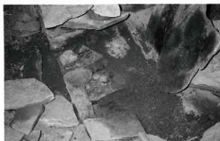
3. 基底部のくさび形石材
