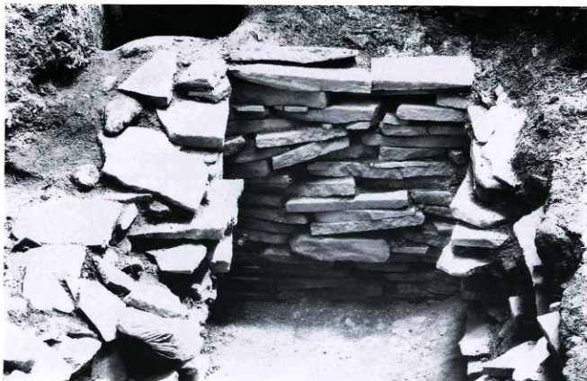
修復前の東短側壁
