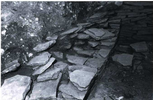
控積みの状況（北長側壁東部）
