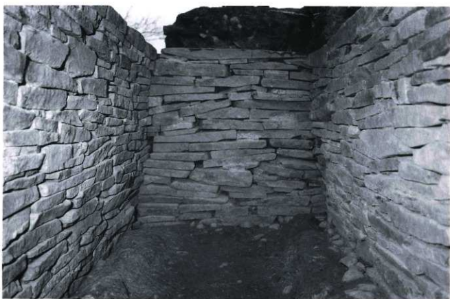
修復後の東短側壁
