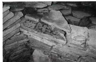
7. 割れた石材の接合（北長側壁西隅）
