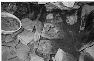
1. 基底部のくさび形石材の接着
