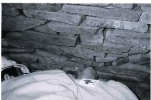
5. 同 側壁材間隙の清掃
