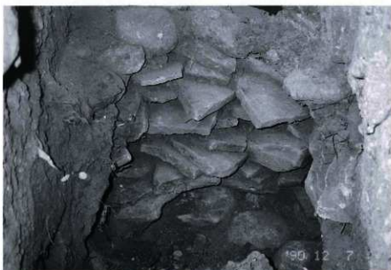
東短側壁に比べ用材が小形 下部にも栗石列がみえる 控積み除去後の西短側壁裏面
