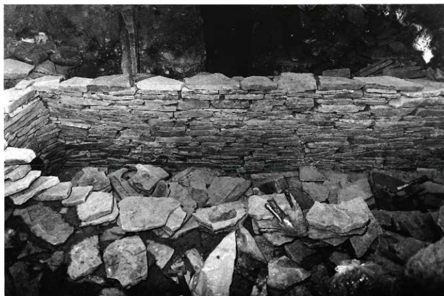
修復後の北長側壁西部（南より）
