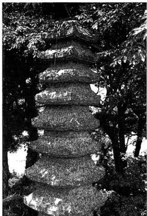
写真2 吉木九重塔上部
