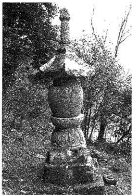
写真58 釜ヶ迫国東塔 修理前
