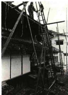
写真59 杉皮を黒根に吊り上げる
