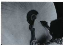
写真51 天井張り(中津市)
