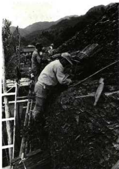
写真57 杉皮葺きの補修（日田市）
