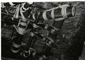
写真62 軒隅の小屋組み(日田市)
