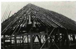
写真61 小屋組み(日田市)
