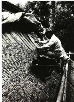
写真60 宇佐神宮の檜皮葺き（中津市）
