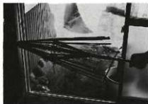
写真48 横込みとつなぎ済みの骨(中津市)
