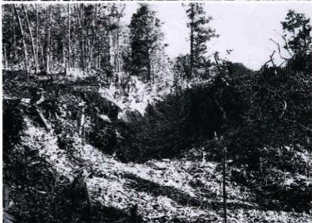
同上 堀の残存状況 (北から)
