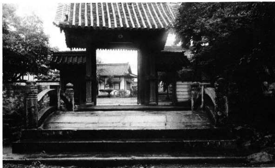
写真2 若宮八幡社石橋
