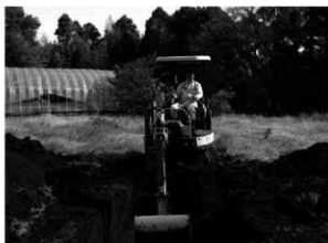
重機稼働状況 (西から)
