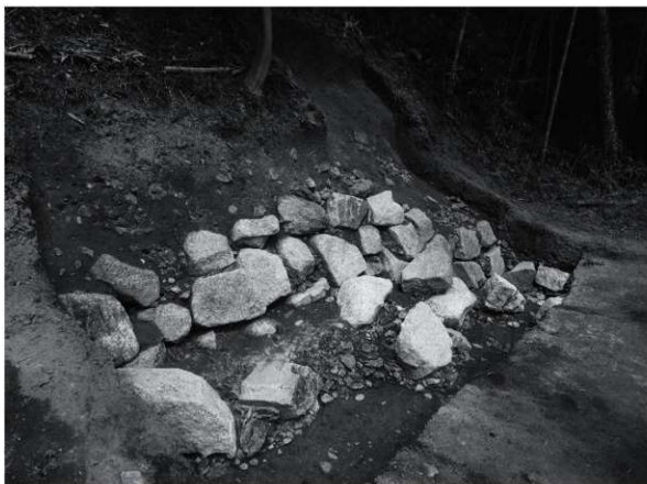
2 4区石垣 (南西から)
