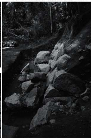
6 4区石垣断面(東から)
