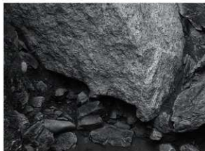
3 4区石材No.31矢穴痕跡（南から）
