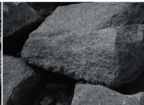
4 4区石材No.7ハツリ痕跡（南東から）
