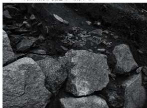
4 4区東壁部分石垣崩落上(南西から)
