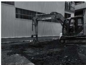
図6 埋戻し風景（南東から）
