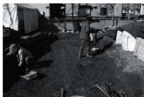
図4 1区作業風景(東から)
