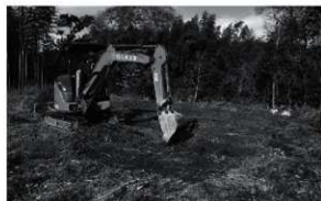
図3 機械掘削作業状況（南西から）
