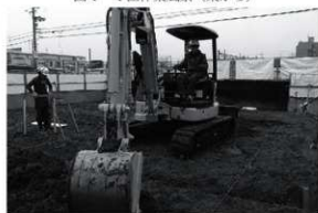
図6 2区重機掘削(北東から)
