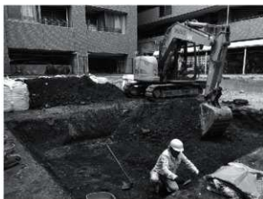
図2 重機掘削風景（南西から）
