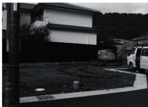
図2 調査前全景（南東から）
