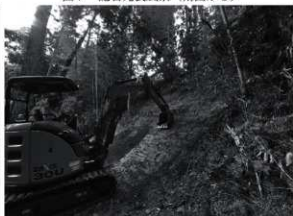
図9 4区埋戻し風景（南東から）
