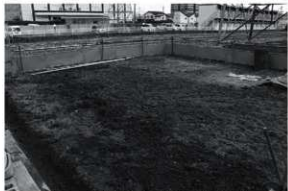
図7 1区埋戻し終了状況(北西から)
