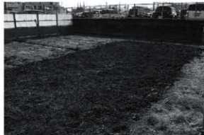
図8 2区埋戻し終了状況(北東から)
