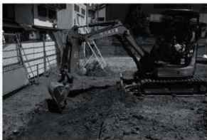
図3 重機掘削状況（南から）
