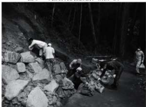
図8 4区土養養生風景（南西から）
