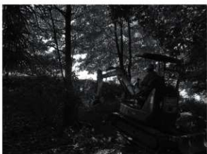
図2 3区重機掘削風景（南東から）
