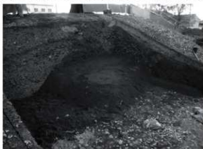
図6 真砂土養生（北東から）
