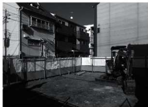
図2 調査前全景（南西から）
