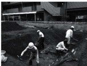
図3 人力掘削風景（南西から）
