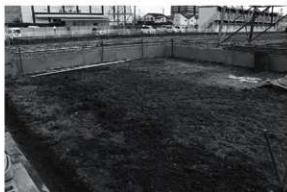
図7 1区埋戻し終了状況(北西から)
