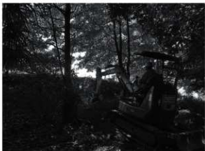
図2 3区重機掘削風景（南東から）
