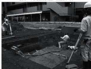
図5 測量風景（南西から）
