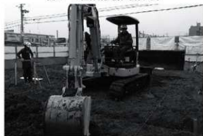
図6 2区重機掘削(北東から)
