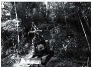
図4 4区重機掘削風景（南東から）
