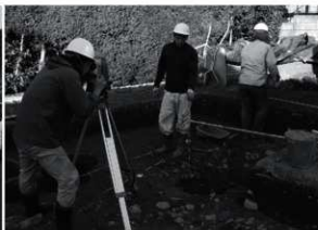
図3 作業風景（南西から）
