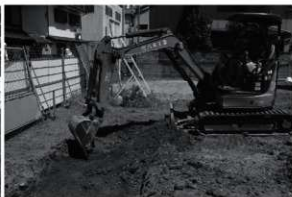
図3 重機掘削状況（南から）
