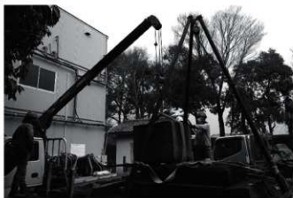
図 66 解体作業風景(南から)
