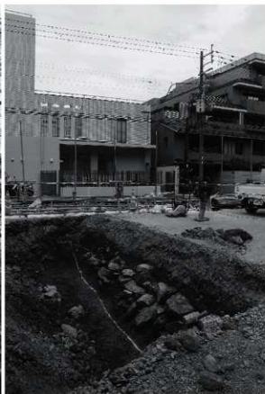
4 No.5地点 暗渠2検出状況(北西から)
