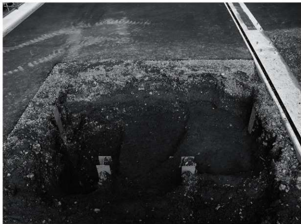
1 3区第2面 全景（南から）
