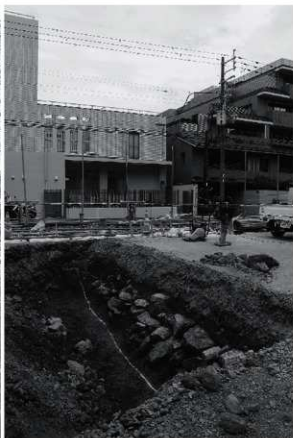
4 No 5地点 暗渠2 検出状況（北西から）
