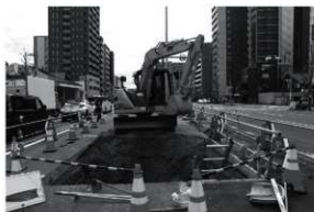
図15 2区掘削状況 (北から)
