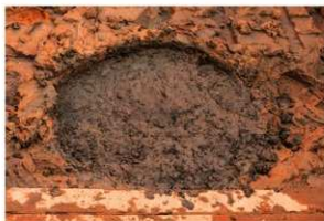
第1号井戸跡掘方 完掘 西から
