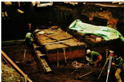
1 倒壊建物移設作業 1
