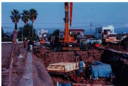
2 倒壊建物移設作業 2
