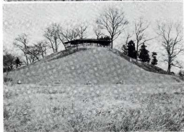
完成後の崩壊崖面保護法面 (同上)
