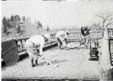
主体部防護柵内踏床改良 (同上)
