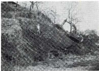
後円部南側崩壊土の除去 (昭和57年度)
