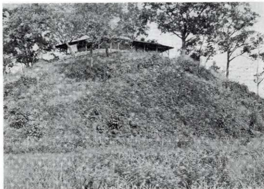
同上（工事実施前）
