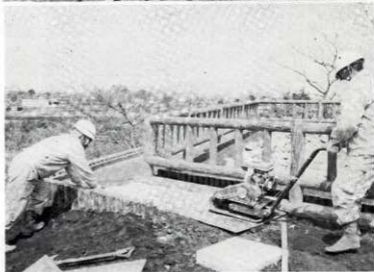
墳頂部通路の踏床改良 (同上)
