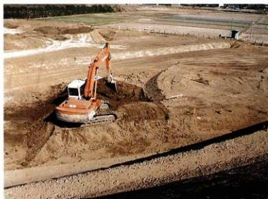
内堀の掘削状況(墳丘上から望む)
