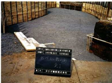
根伐後、敷砂利完了
