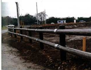
擬木柵の設置
