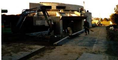
施設は半地下構造となっている
