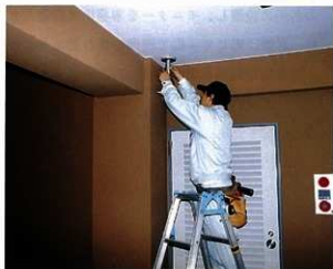
放送設備工事状況
