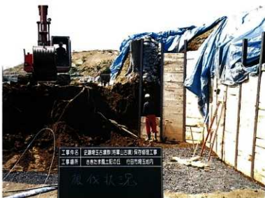
矢板による土留めと根伐状況
