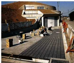
アブローチタイル貼り工事
