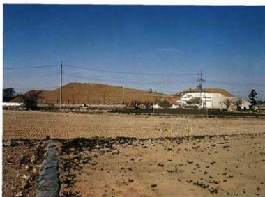
盛土工事完了（東側）
