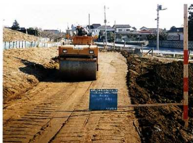
盛土工事転圧状況（4層目）
