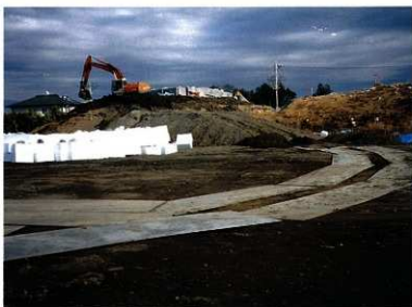
EPS工法による施工
