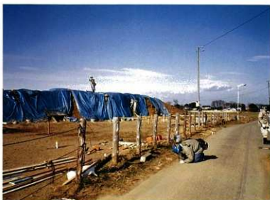
着工前の測量・位置出し
