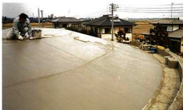
左官工事による仕上げ（屋根部分）
