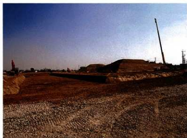
周堤実物大復原工事概観
