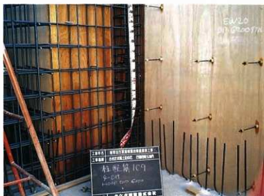
鉄筋配筋状況（柱）
