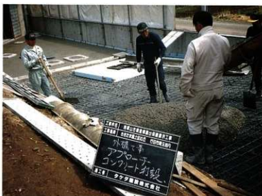
外構工事の状況（アプローチ部分）
