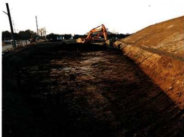
掘底のレベルを確認する
