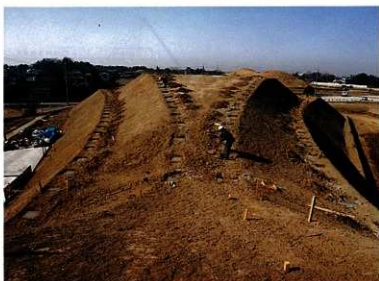
コンクリート基礎設置状況
