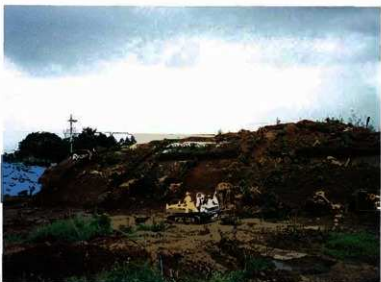
填丘すき取り工事（左後方）
