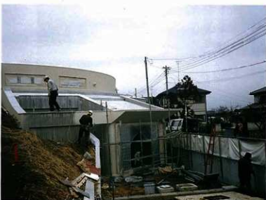
施設外壁塗装状況
