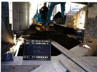
埋め戻し状況（1階床部分）
