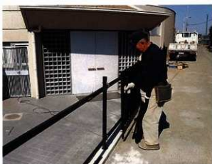
格子柵の設置
