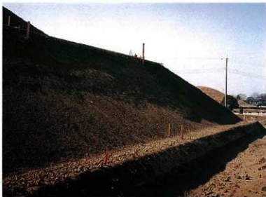
前方部法面の整形状況
