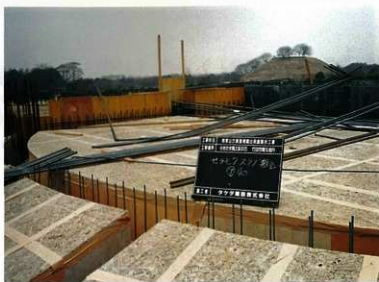
セラモクスラブ敷込（屋根部分）
