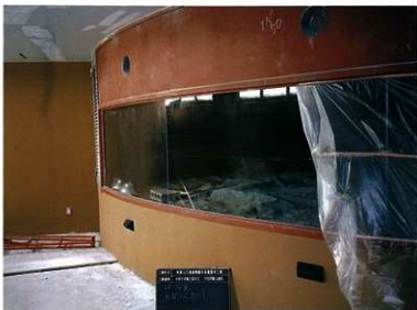
石室前面のガラス取付け
