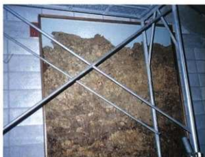
土層パネル取付完了
