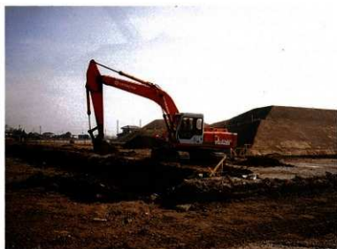
外堤掘削工事状況
