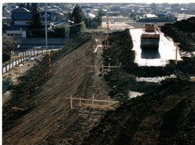
前方部 2 段目盛土転圧状況
