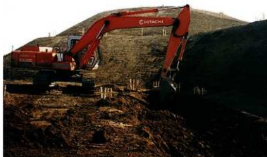
内堀の掘削状況 (西側くびれ部付近)
