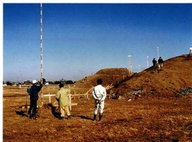
平成8年度 盛土工事前の測量
