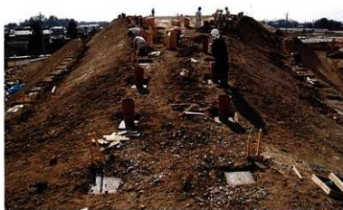
埴輪配列工事状況
