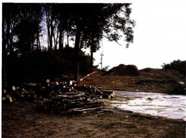
伐木施工状況
