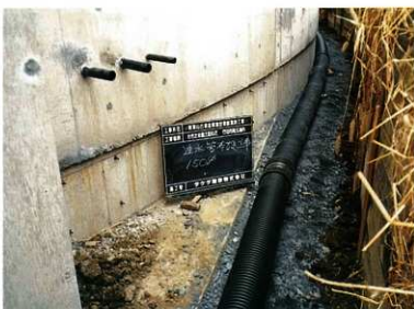
透水管布設工事
