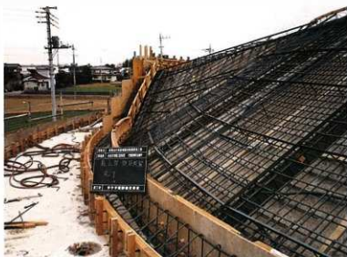
鉄筋配筋状況（屋根部分）
