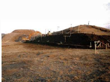
前方部西側盛土状況
