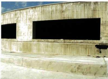
コンクリート崩落部分を養生する
