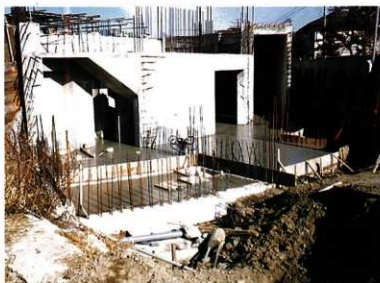
コンクリート打設状況（入口付近）
