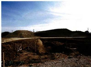
中堤造出し部分を復原する
