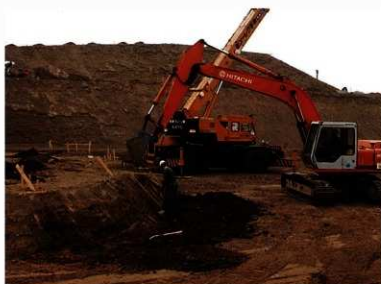
内堀の掘削状況(造出し付近)
