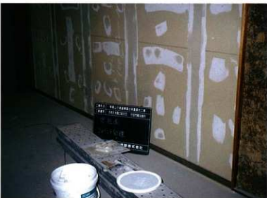
内壁吹き付け下地処理（一階）
