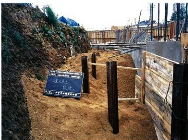
透水管埋め戻し状況
