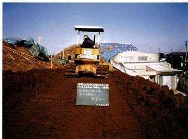
盛土工事転圧状況（8層目）
