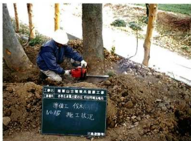
伐木施工状況
