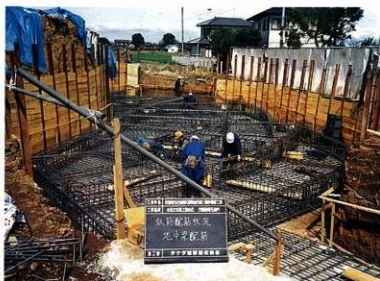
鉄筋配筋状況 (地中梁)
