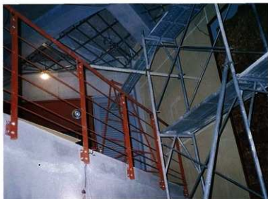
手摺取付け完了（2階・吹抜け）
