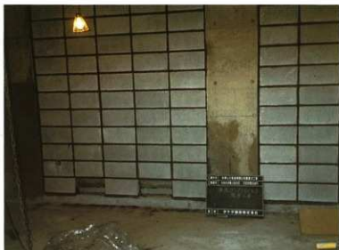
コンクリートブロック工事
