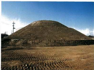
後円部盛土工事完了
