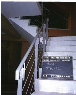
手摺部分塗装仕上げ完了
