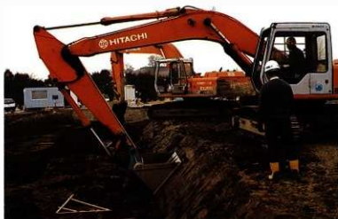
法面整地工事の状況
