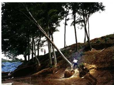
伐木施工状況
