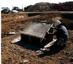
解説板土台工事
