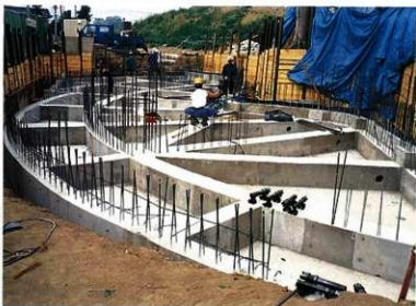
基礎ベース 型枠解体完了 (地中梁)
