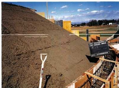
コンクリート打設完了（屋根部分）
