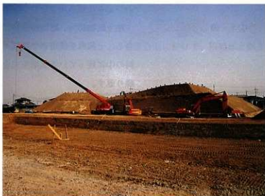
埴輪設置工事概観
