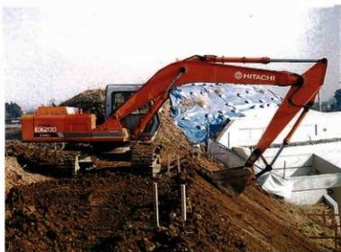
前方部1段目の法面整形
