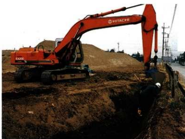
法面は 1 : 1 の法勾配に設定
