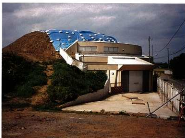
内装工事はほぼ完了の施設外観
