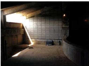
躯体工事中の石室前
