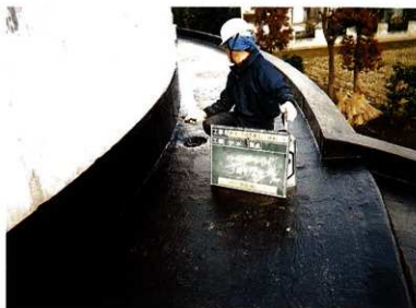
防水工事 ハルコート塗布（屋根部分）
