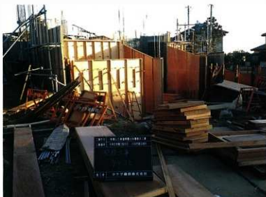
型枠工事建て込み状況
