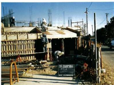
型枠工事・スラブ上げ
