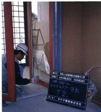
エンジンドア塗装（1階ロビー）
