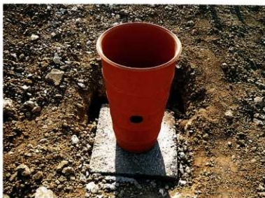
コンクリート基礎にボルト留めする
