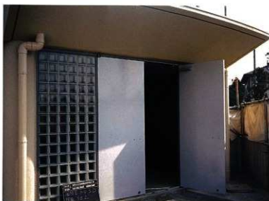
風除室入口ドア塗装仕上げ完了
