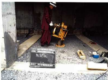
転圧状況（1階床部分）
