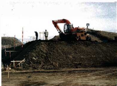
前方部隅角部を整形する
