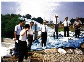
石室部分の工事状況を視察 (H6)
