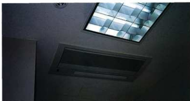
空調設備・照明器具取付（事務室）
