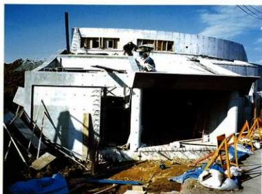
躯体工事中の施設外観
