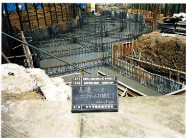
基礎ベース コンクリート打設完了
