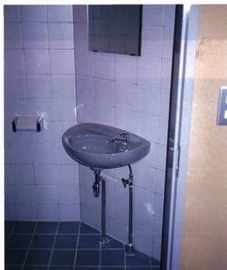
タイル貼り工事完了（便所内） 手洗器・鏡・便器取付け完了（〃）
