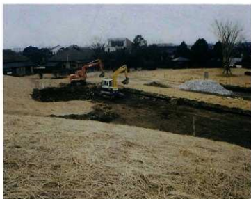
写真149 墳丘西側周堀部分の掘削
