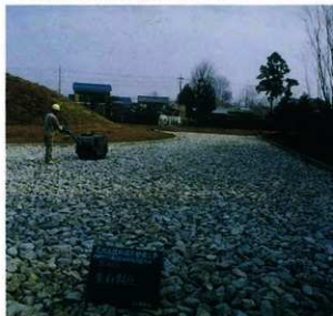
写真147 墳丘東側内堀の立体表示工事
