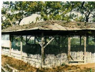
写真101 整備前の礫柵覆屋
