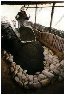
写真105 礫層の埋め戻し
