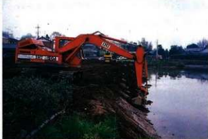
写真170 前方部周堀整備工事（平成2年度）
