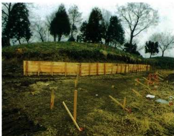
写真141 杉丸太と松板による土留工
