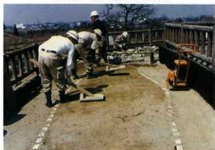
写真110 主体部防護柵内の表層仕上げ
