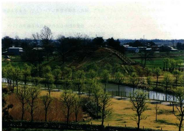
写真115 整備完了直後の稲荷山古墳
