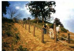
写真132 階段手すりの設置
