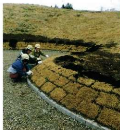
写真151 墳裾部芝張り工事
