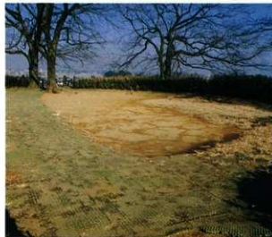
写真136 芝防護マットの現状
