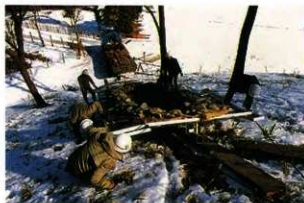
写真107 礫柵レプリカの据付
