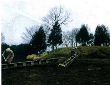
写真142 墳丘東側の盛土工
