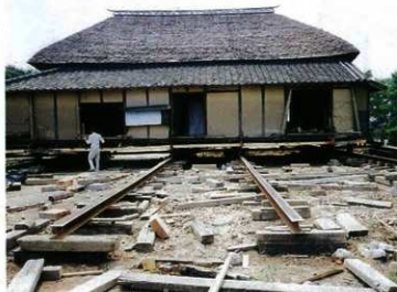
写真154 山崎家曳家工事 (レール上を移動)
