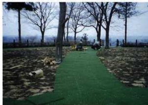
写真124 見学コース用芝防護マットの設置
