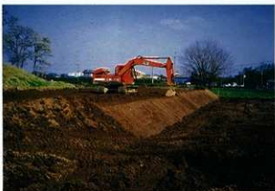
写真169 前方部周堀整備工事（平成2年度）
