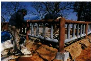
写真108 主体部防護柵の設置
