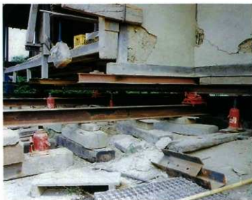
写真153 山崎家曳家工事 (ジャッキによる持ち上げ)
