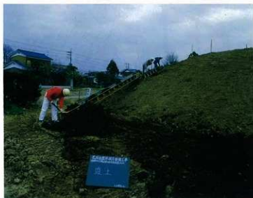
写真146 墳丘西側の盛土工
