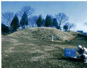
写真144 昭和63年度工事の完成
