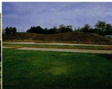
写真152 平成2年度工事の完成一西から
