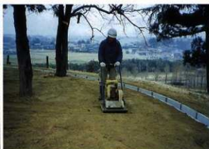
写真123 墳頂部盛土叩きしめ
