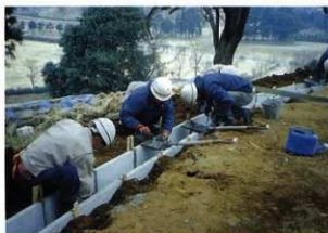
写真122 墳頂部周囲の排水用U字側溝の設置
