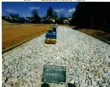
写真150 周堀床面栗石の転圧
