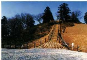
写真133 完成した正面階段
