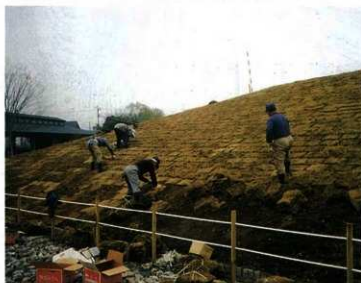
写真158 前方部正面芝張り工事
