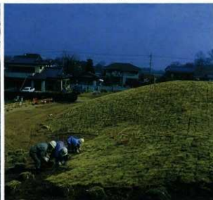
写真148 墳丘西側の芝張り工事
