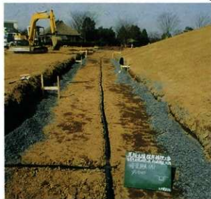
写真155 前方部正面部分の暗渠排水溝
