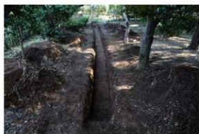
IV区25-3トレンチ完掘
