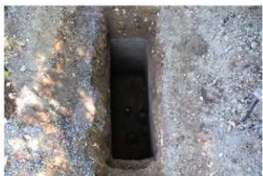
IV区26-37トレンチ完掘
