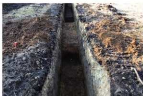
III区24-10トレンチ完掘
