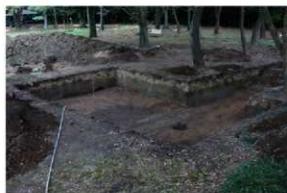
V区22-1-4トレンチ完掘
