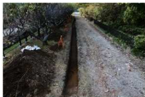
IV区25-4トレンチ完掘
