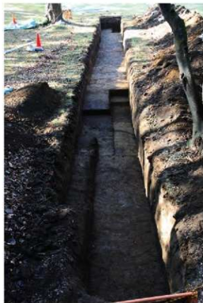
III区27-44トレンチ完掘
