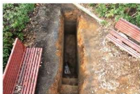
IV区26-30トレンチ完掘
