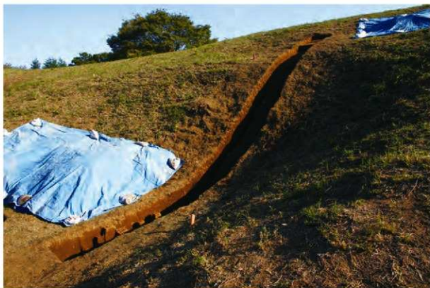
II区24-3トレンチ安土構築状況（看的所土塁から）
