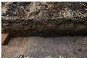
III区27-43トレンチ外堀土層断面
