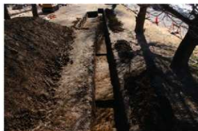
IV区24-8トレンチ完掘
