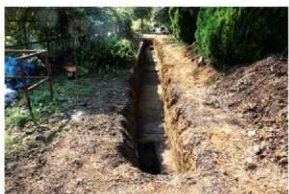
IV区25-2トレンチ完掘
