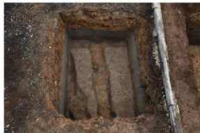
IV区26-33トレンチ完掘
