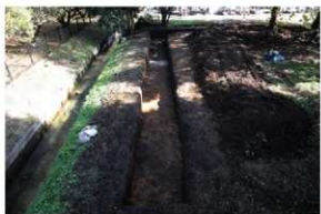
IV区25-1トレンチ完掘
