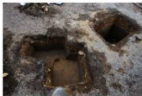
IV区23-8-6トレンチ完掘
