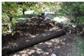
IV区25-1トレンチ完掘
