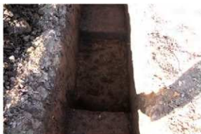
IV区24-7トレンチ完掘
