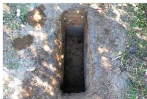
IV区26-38トレンチ完掘
