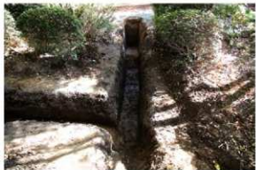
IV区25-14トレンチ完掘
