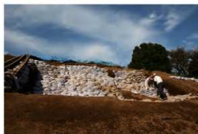
III区28-42トレンチ埋め戻し
