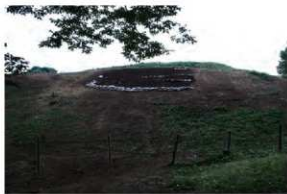
III区28-42トレンチ埋め戻し完了
