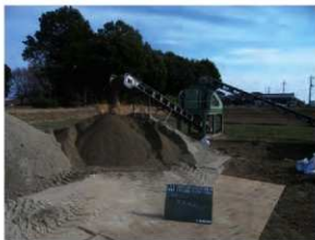
復原整備工（プラント稼働状況）
