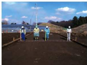
復原整備工（中堤路床完成）
