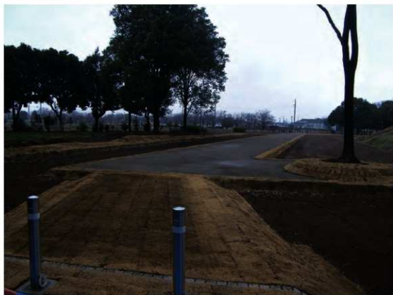
完成（内堀・外堀の張芝は平成23年度工事）
