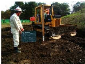
盛土工（敷均し・転圧）
