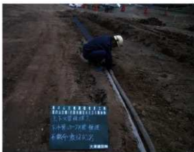
上下水道保護工
