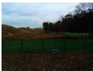
着工後（墳丘東側）
