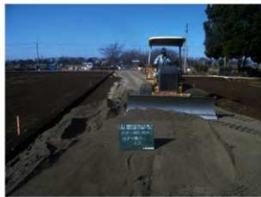
復原整備工（改良土敷均し）
