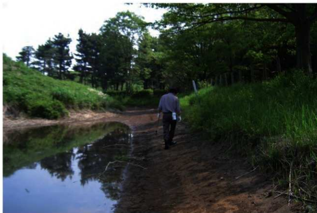
調査・整備前の状況調査 (墳丘裾部が一部崩落。法面はローム層が露出し、遺物が散在する。平成19年5月撮影)
