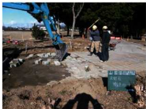
施設撤去工（大谷石撤去）
