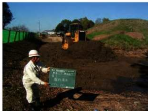
盛土工（敷均し・転圧）
