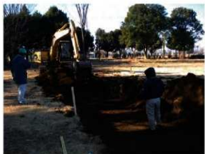
整地工（外堀部の鋤取り）
