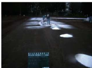
舗装工（塩化カルシウム散布）
