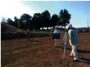
仕上げ高検査
