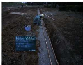
縁石工（裾底表示石用基礎コンクリート）
