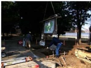
施設撤去工（案内看板移設）
