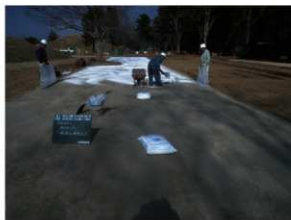
復原整備工（塩化カルシウム散布）
