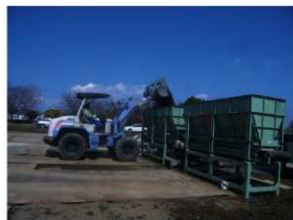
復原整備工（改良土舗装用混合プラント）
