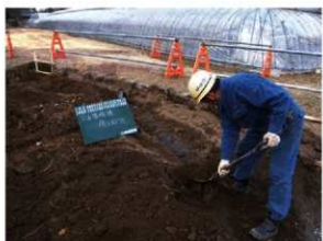
整地工（下水管保護）
