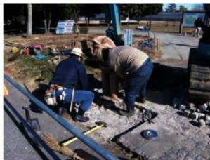
施設撤去工（オブジェ撤去）
