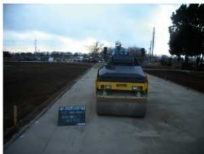
復原整備工（改良土転圧）
