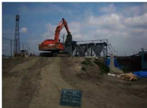
舗装工（改良土混合状況）
