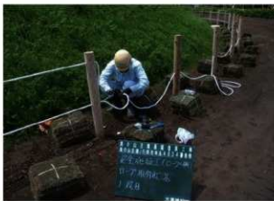
安全施工（ロープ橋）
