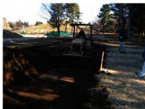
整地工（外堀部の整地）
