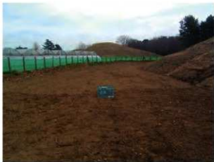
着工後（造出し部周辺）
