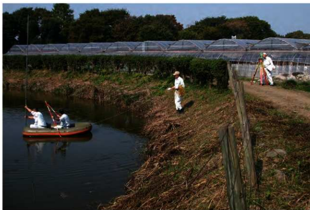
内堀の深度調査(平成20年10月) (3Dレーザー測量では水面下は計測不能なため、手測りによる補足測量)
