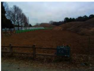
着工後（墳丘西側）
