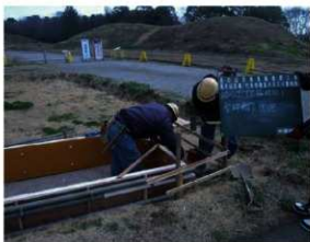
史跡標柱（型枠組立）
