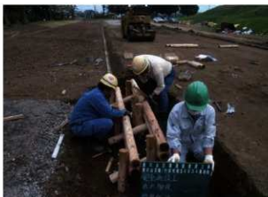
安全施設工（丸太階段）
