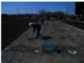
復原整備工（改良土不陸整正）
