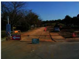
仮設工（敷鉄板）
