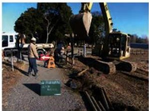
施設撤去工（擬木柵撤去）
