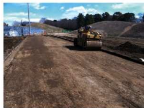
復原整備工（中堤路床転圧）
