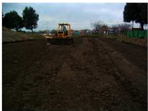
盛土工（敷均し・転圧）
