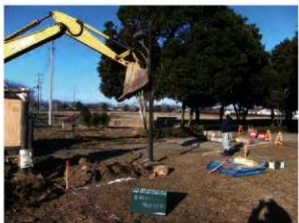
施設撤去工（園路灯撤去）
