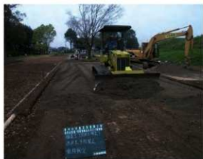
舗装工（改良土舗装）
