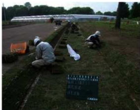
張芝工（外堀法面）
