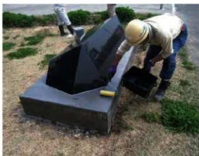
史跡標柱（吸水防止剤塗布）
