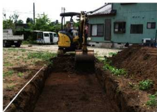
2. 重機による掘削状況 (北西→)
