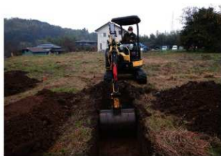
2. 重機による掘削状況 (南西→)
