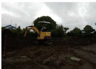
7. A区埋戻し (北西→)
