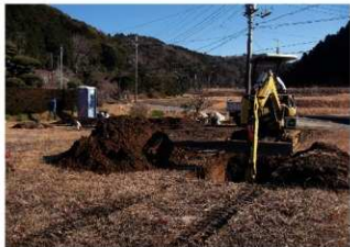
2. 重機による3T掘削状況 (南西→)
