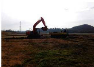
3. 重機による掘削状況 (北→)
