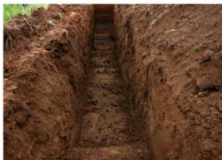
2. ③トレンチ完掘 (北→)
