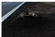
修景工（塚復元、集石再設置）
