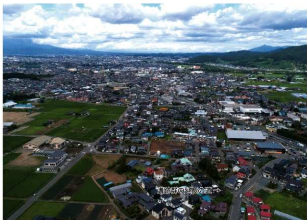
写真3 調査区遠景 (上空 南から)
