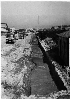
A地区東側擁壁部全景（南から）
