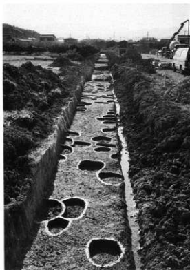
A地区東側擁壁部全景（北から）
