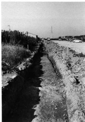
A地区西側擁壁部全景（南から）
