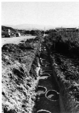
A地区西側擁壁部全景（北から）
