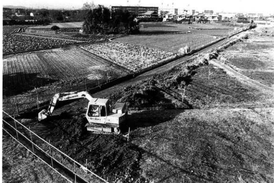
トレンチ掘削状況
