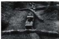
石管水道と石組排水溝（鹿市教委1992）
