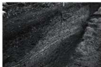
土壁(令和2年度調査)
