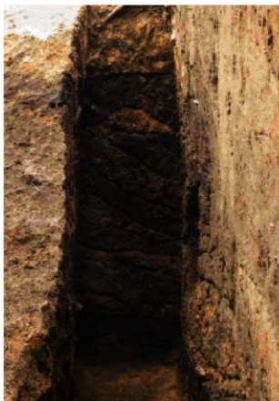
(4) 第2トレンチ斜面部盛土断面 (東より)
