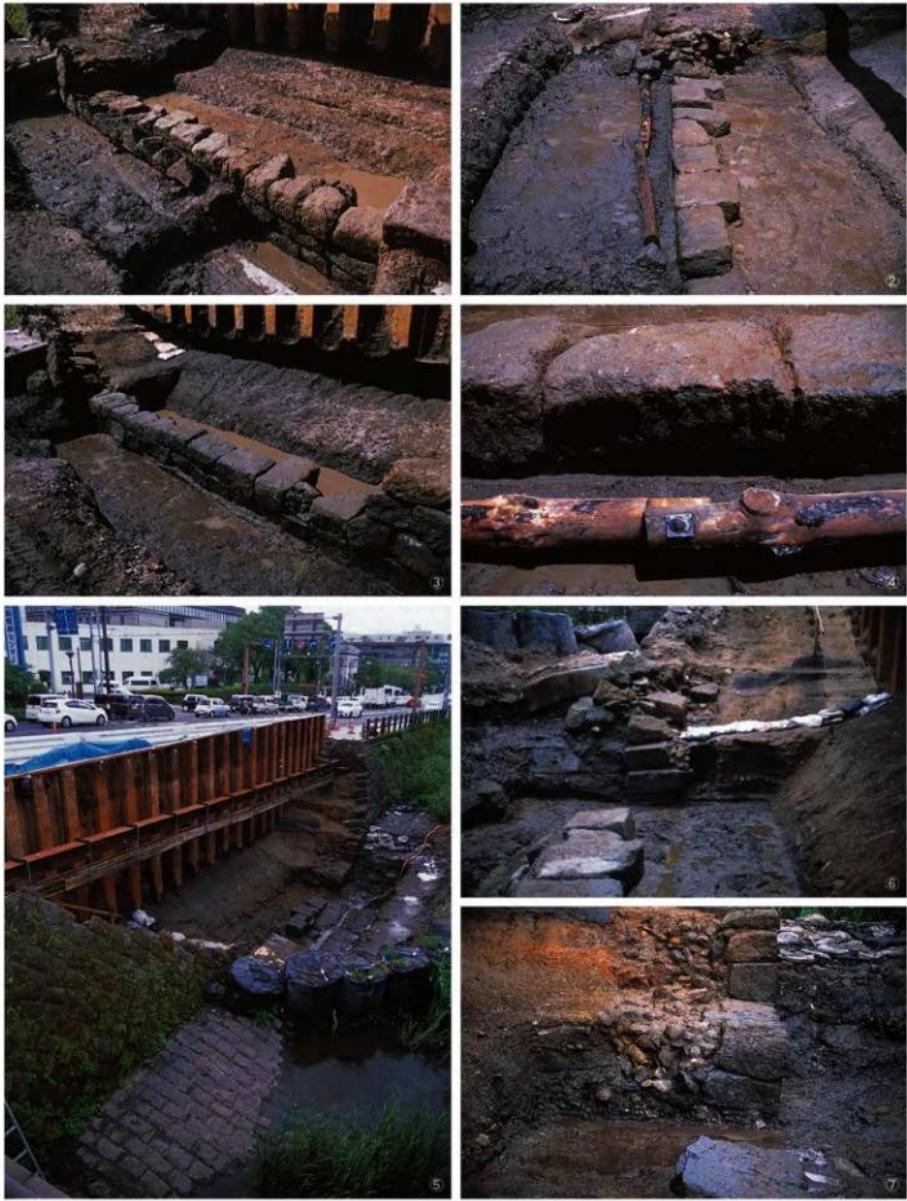
① 北御門跡石垣修復トレンチ布積石垣株出状況（北西から） ② 北御門跡石垣修復トレンチ崩木株出状況 ③ 北御門跡石垣修復トレンチ石垣（下二段）株出状況
