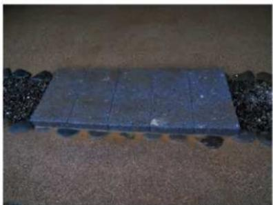
雑工事 -7 雨落ちの通路部分に板石を設置した
