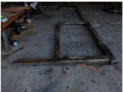
解体時 -24 土台材 腐朽状況
