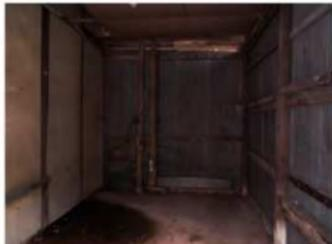
7-1-9 解体前の内部の様子 トタン波板で囲われ、床はコンクリートとなっている。
