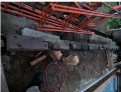
建て方・屋根-6 出桁 手前部分は腐朽により継木
