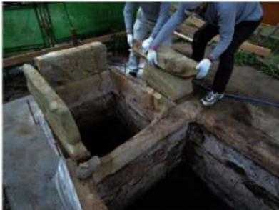
基礎-5 石材を強化処理（SS101）後、再設置
