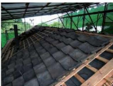
建て方・屋根-10 野地板・杉皮の上に補強として、合板・アスファルトルーフィングを敷設
