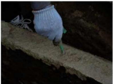
基礎 -7 ステンレスアンカーピンによる固定
