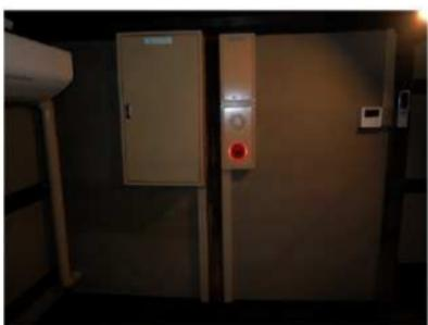
3-5-102 総合盤と感知器のボックスは長屋 2 の 1 階に設置した
