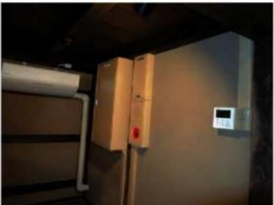
設備 -4 長屋 2 の総合盤と感知器のボックス
