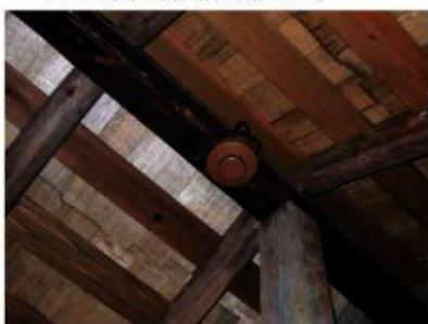
3-5-101 棟木下に設置した煙感知器
