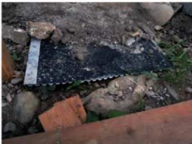
雑工事 -5 雨落ち下に板状排水材を設置した
