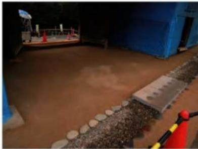
3-5-92 門戸部分の土系舗装仕上げの施工状況
