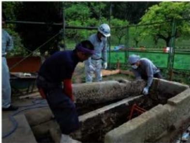
基礎-4 石材を強化処理（SS101）後、再設置
