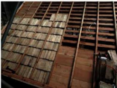
3-5-59 野地板の上に野垂木を新設し、その間にササイタを葺いた
