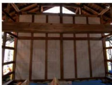
3-5-76 壁下地の荒壁パネル施工状況
