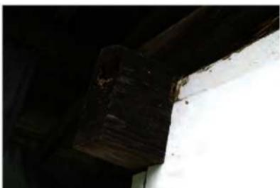
修理前 -8 出桁西端 腐朽状況
