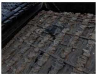
7-1-7 カンソウバ屋根下地 瓦を下ろし、屋の下地が確認できる。土葺で下地のササイタと煙突の跡が確認できる。
