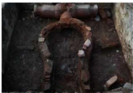
7-1-14 炉内の石を除去、奥の配管が見える
