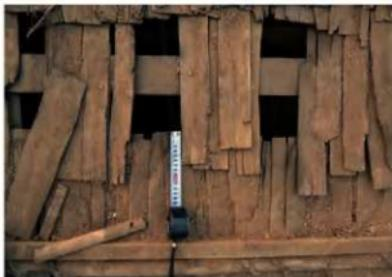
3-5-40 ササイタの葺き重ね(縦)は70~90mm程度で(横)は15~20mm程度
