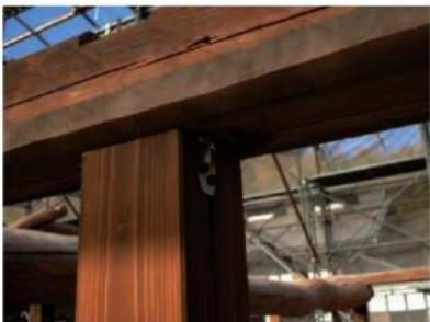
構造補強 -6 柱と土台・梁・桁の接合部で見え隠れとなる箇所に耐震 L型金物を設置した
