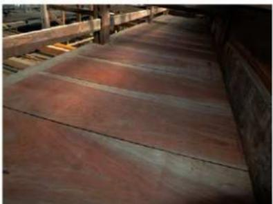
木工事-20 平天井の檜板は既存材と同寸法のものを西側へ使用した
