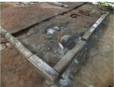
解体後 -8 ドマ東側通り 地覆石が沈下した部分
