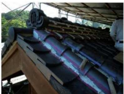
屋根・壁-11 新規瓦を補足し屋根葺き、漆喰固め
