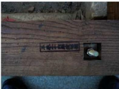
建て方-5 土台 新補材には焼印押し
