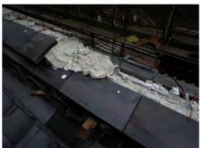
3-5-69 棟積みは棟と並行に設置したステンレス筋に結んだ
