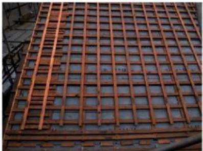
3-5-65 防水紙施工後、下地に瓦棟を設置した
