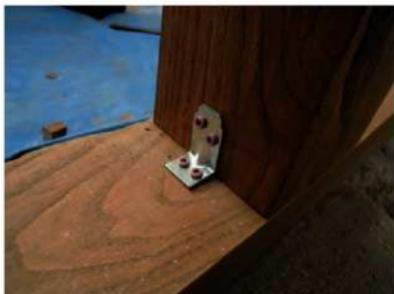
構造補強 -5 柱と土台・梁・桁の接合部で見え隠れとなる箇所に耐震 L型金物を設置した
