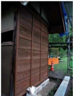
屋根・壁-9 東面下見板壁 壁板取替え
