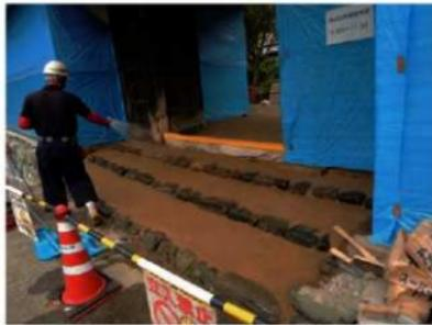
3-5-91 長屋門入口部分の土系舗装仕上げの施工状況
