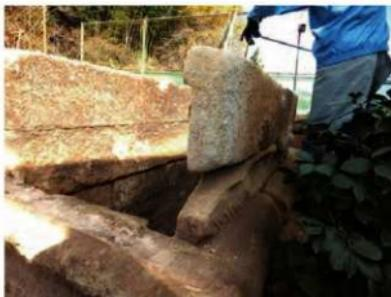
解体後-6 地覆石の磨滅が激しい
